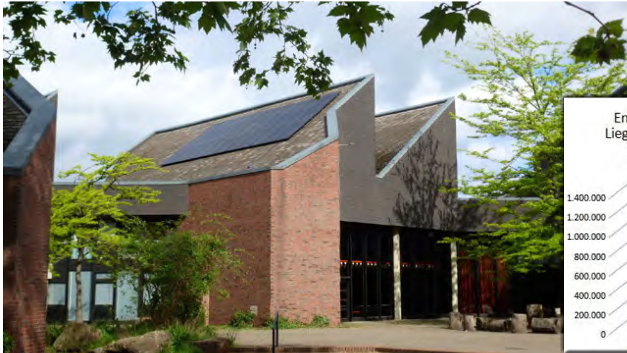
Photovoltaik-Anlage auf dem Dach des Gemeindehauses der Evangelischen Gemeinde Düren, 2019.
