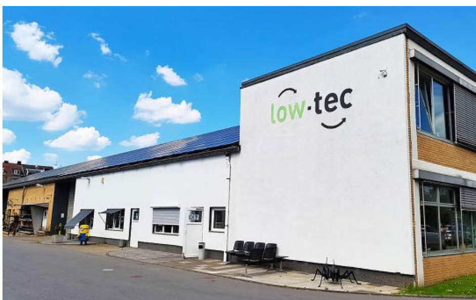
Firmengebäude der low-tec am Standort Düren.
